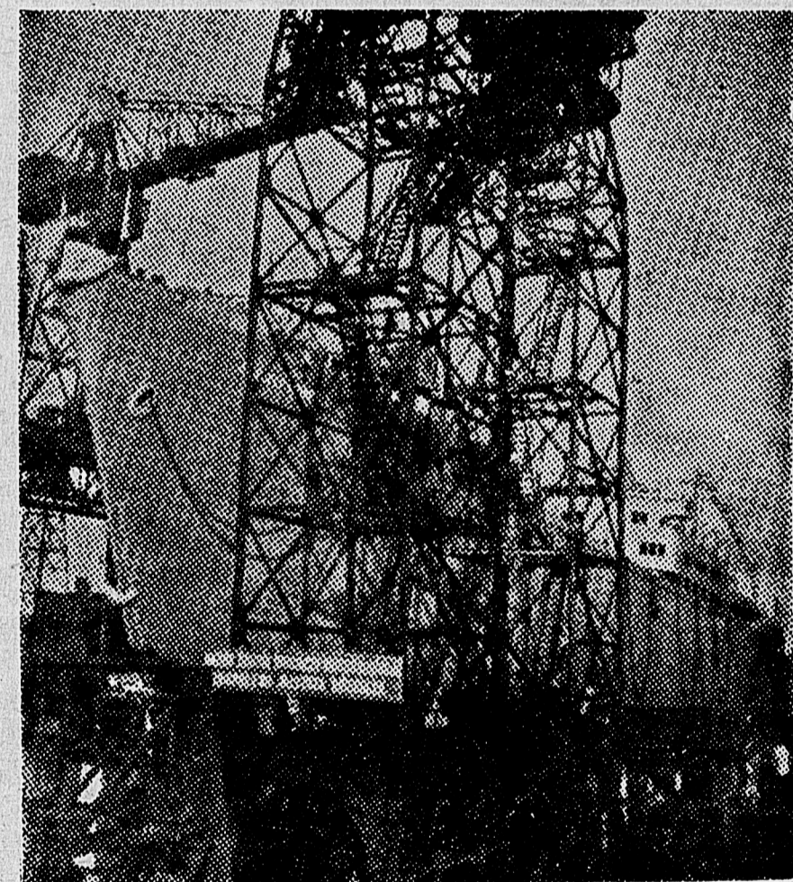
Um estaleiro polonês em atividade
