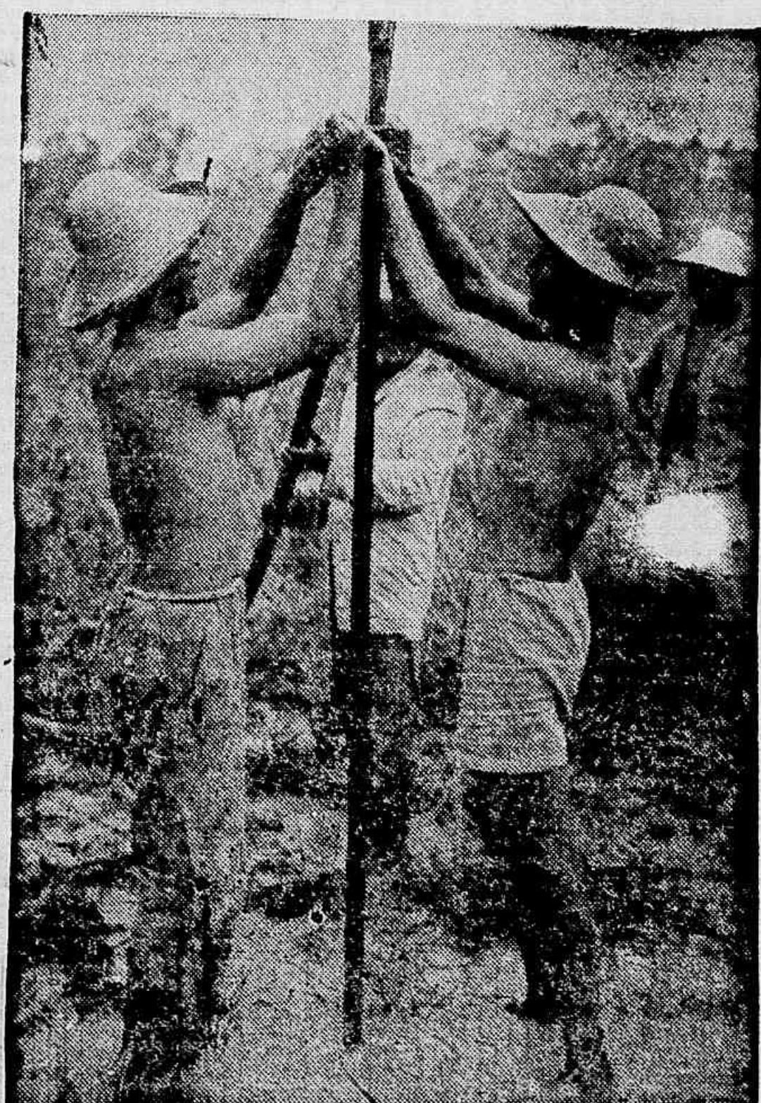
Trabalhos iniciais para a perfuração de um dos poços de Nova Olinda. Quando, a qualquer momento, a notícia da obtenção de um poço produtor no referido área petrolífera.
