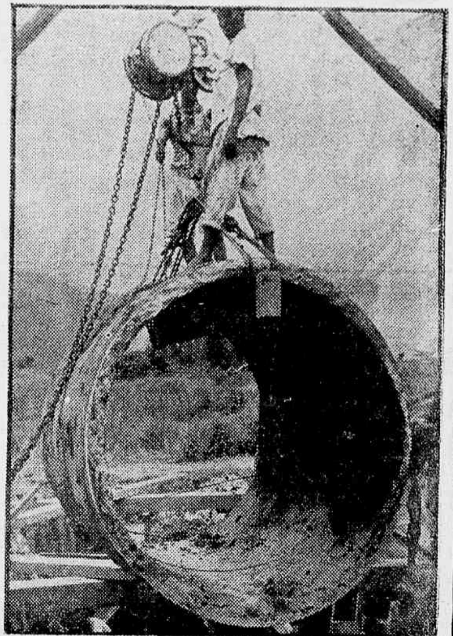
A Prefeitura gastou centenas de milhões de cruzeiros para construir a adutora (segunda) do Ribirão das Lages. A companhia americana Tetracap (cuja intervenção no problema da água no Rio é uma história de negociatas) empregou material condenado pelo Instituto Nacional de Tecnologia. Os tubos frequentemente arrebentam, obrigando a novas despesas e deixando milhares de pessoas sem água. Na foto, a substituição de um dos tubos (arrebentado) da adutora.
