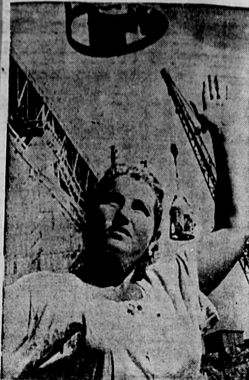
Ekaterina Denisova, operária na construção de uma hidrelétrica na URSS, comanda uma grua de assentamento de concreto armado com precisão e maestria.
