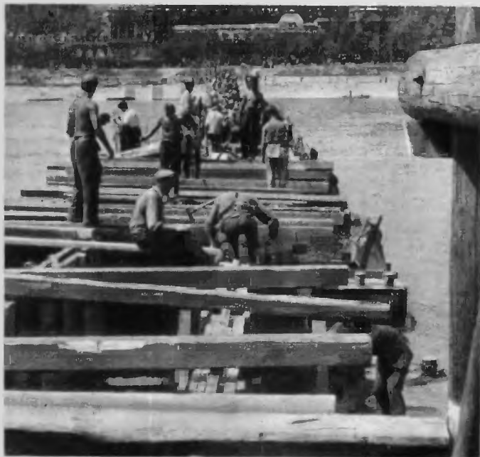
Az ideiglenes „Manci-híd” építése
