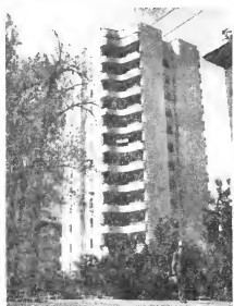
Экспериментальный 12-этажный жилой дом в г. Алма-Ате.
