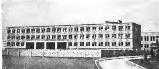
Здание средней школы в г. Рудном, построенное по новому проекту.
