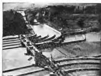
Плотина на р. Чу.
