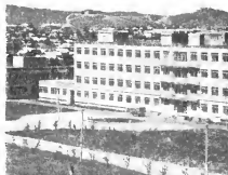
Кокчетав. Новый больничный комплекс.
